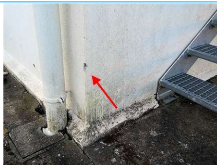
Matériaux : ZPSO-001 Prélèvement : P002 Description : Enduit extérieur Localisation : Bat 50 - Facade Résultat : Absence d'amiante
